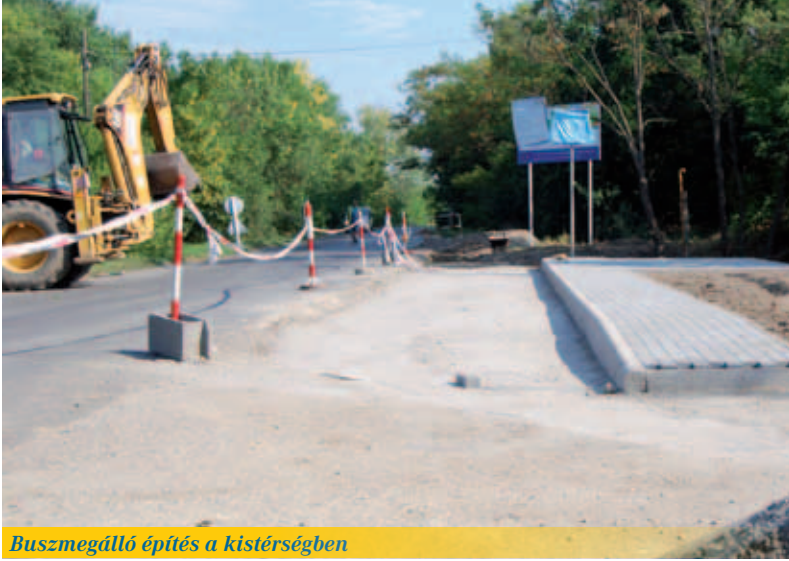
Buszmegálló építés a kistérségben
